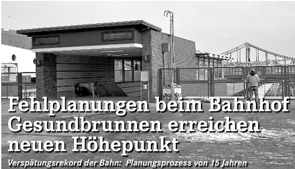
Bahnhof Gesundbrunnen: Komfort – vielleicht in der Zukunft
