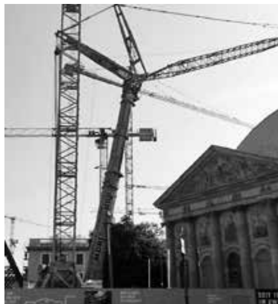
Baustellen rund ums Jahr überall in Mitte
