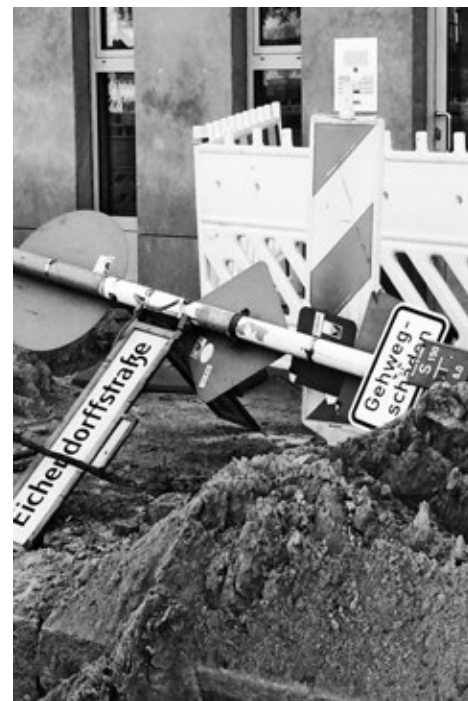
Baustellen an allen Ecken und Enden
