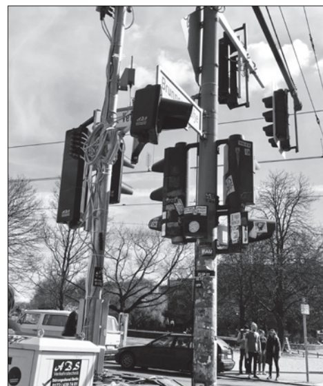
Baustellenwirrwarr in der Innenstadt
