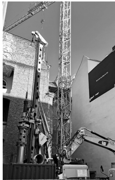
Tief nach unten und hoch hinaus auf Mittes Baustellen
