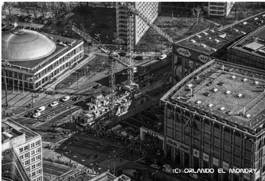
Die Baugrube des Alexander Capital Tower (links neben dem Würfel des Alexa-Gebäudes)
