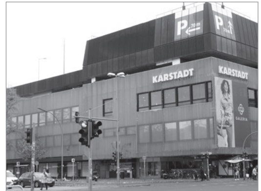
Karstadt-Gebäude am Leopoldplatz
